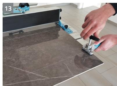
**Aiutarsi con il separatore in dotazione per aprire i primi 15/30 cm della piastra da entrambi i lati della lastra.**
